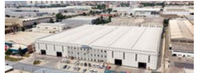
Bursa Servis Merkezi, Bursa/Türkiye
